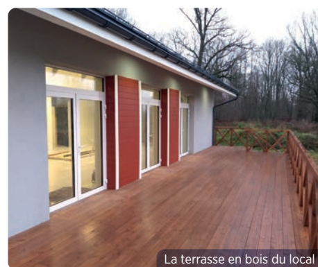
La terrasse en bois du local
